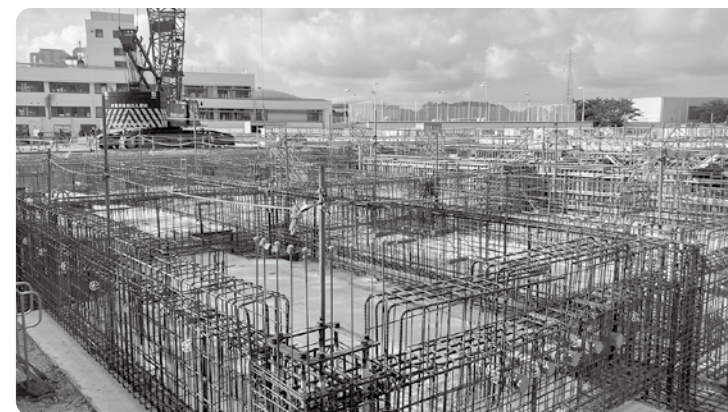
躯体工区 — 鉄筋・型枠の施工状況 (2026.8.20 現在)
