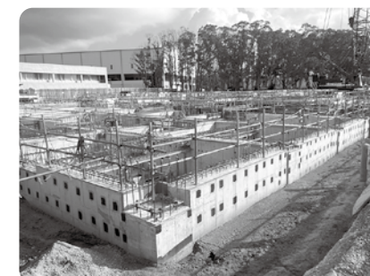
外周部埋戻し (2026.9.1 現在) 埋戻し：建物の基礎や地下構造物の外側の周囲 (外周部) にできた隙間や空間に、土や砂利を埋め戻して地盤を整える作業のこと。
